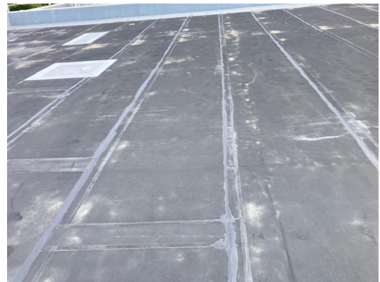
シート部分補修、ジョイント分充填処置
