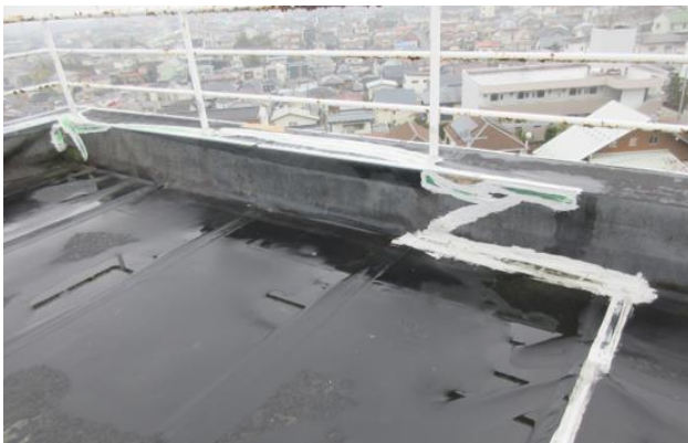
シート防水補修前(シールで応急処置)
