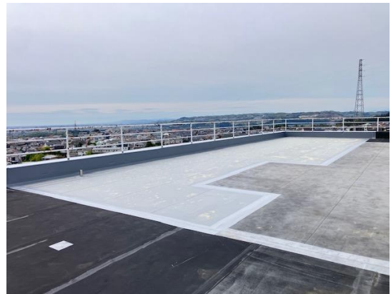
シート防水補修完了(不良箇所撤去)
