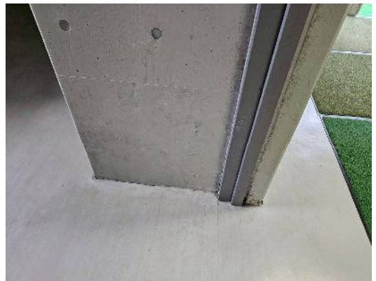
1 号館 2 階手洗い袖壁補修後
