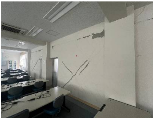
本館教室内補修前
