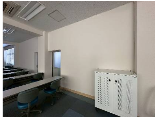
本館教室内補修後
