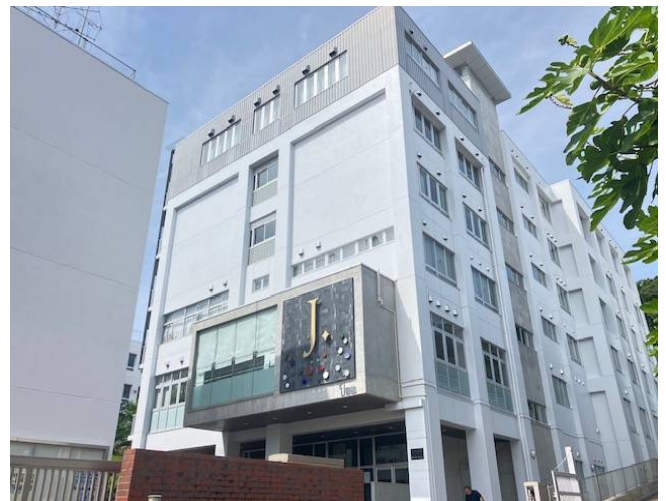
1 号館東面・北面外壁完了写真
