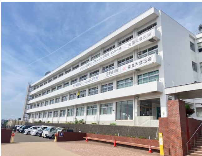
本館東面外壁完了写真
