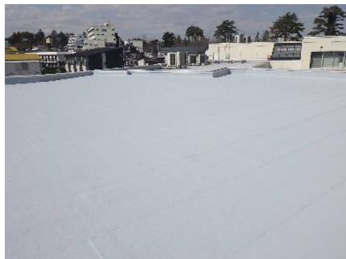
8 号館屋上防水補修完了
