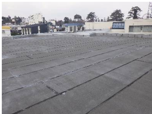
8 号館屋上防水改修前
