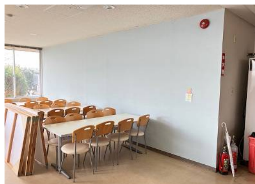
壁クロス張替完了
