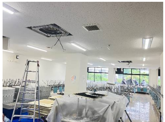
空調機 入替中
