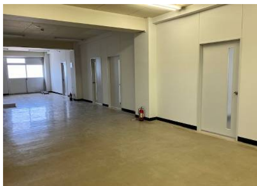
6 号館 4 階改修後
