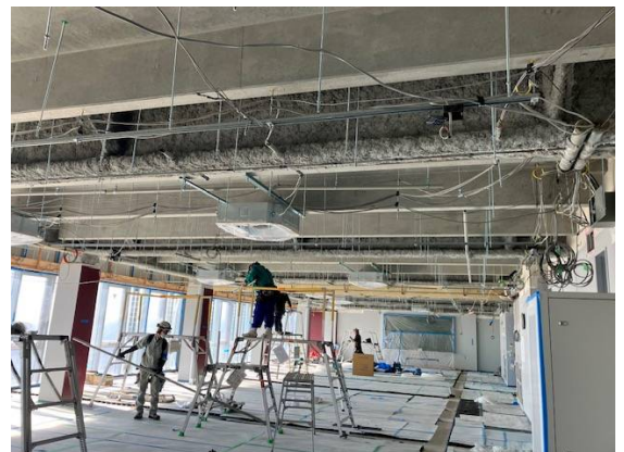
10 号館 7 階解体状況
